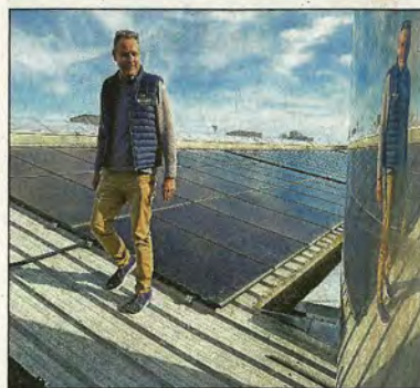
Steven Kärigel auf dem Dach der Füllhalle: Mit der neuen Photovoltaik-Anlage will der Winzerverein Deidesheim 15.000 Euro an Stromkosten sparen. FOTO: SNR
